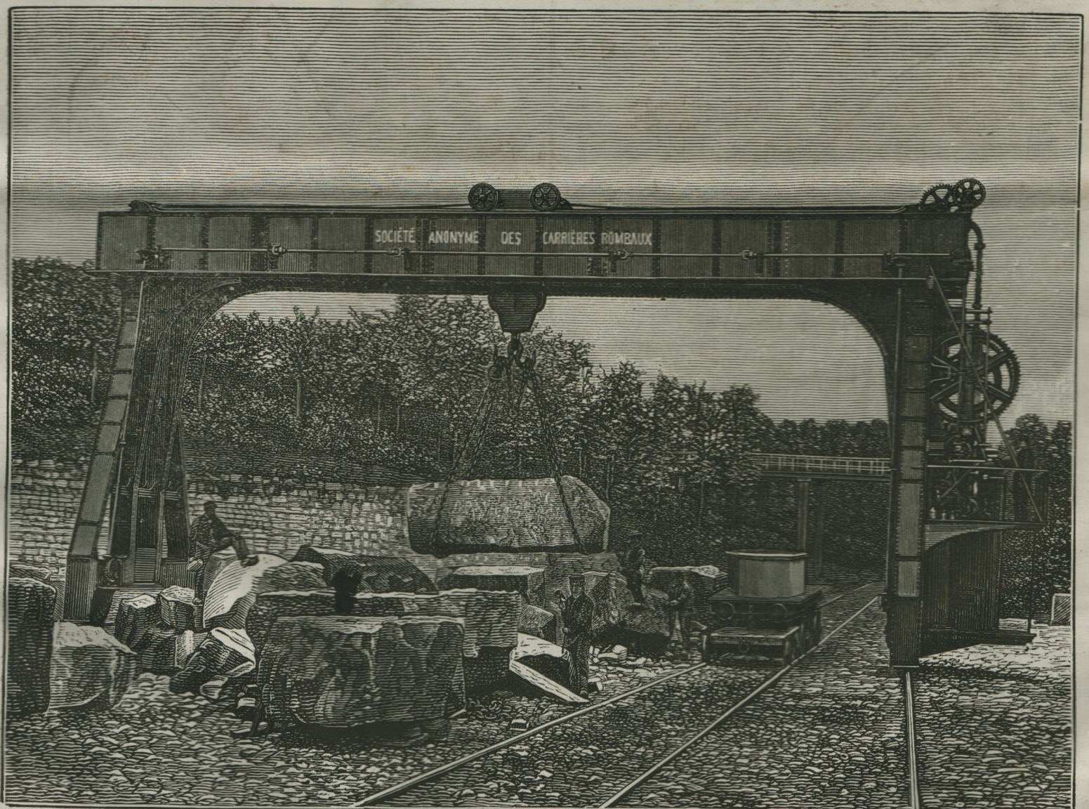
CHANTIERS DE LA SOCIÉTÉ ANONYME POUR L'EXPLOITATION DES CARRIÈRES ROMBAUX.
